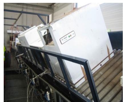
Abb. 6: Kühlgeräterecycling UFH, Kematen (© UFH RE-cycling GmbH, 2018)
